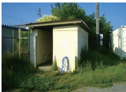
▲改修前の富貴小グラウンドトイレ
